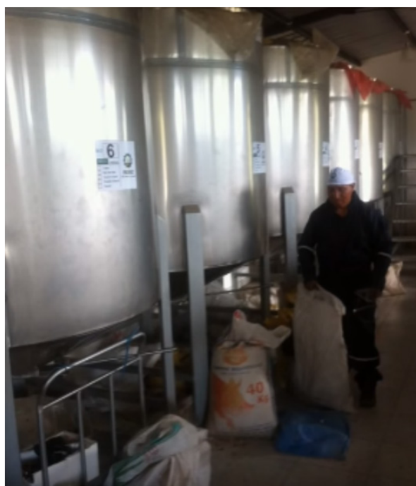
Imagen 1. Silos de almacenamiento del Centro de Acopio
